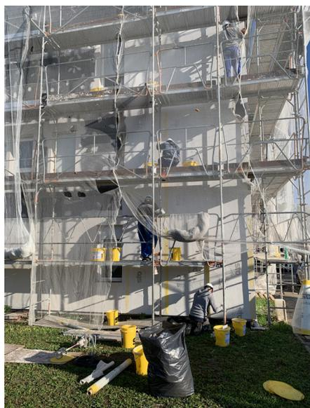
Visant le label BBC Effinergie Rénovation et par là même une réduction conséquente de la consommation énergétique des logements, Habitats de Haute-Alsace procède systématiquement au remplacement des fenêtres, à l'isolation thermique par l'extérieur, à l'installation d'un système de ventilation hygroréglable ou encore à la rénovation des équipements techniques.
