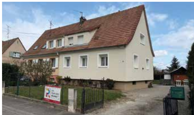
Réhabilitation complète d'un pavillon à Wittenheim (isolation thermique par l'extérieur, remplacement des menuiseries extérieures et de la toiture,...)
