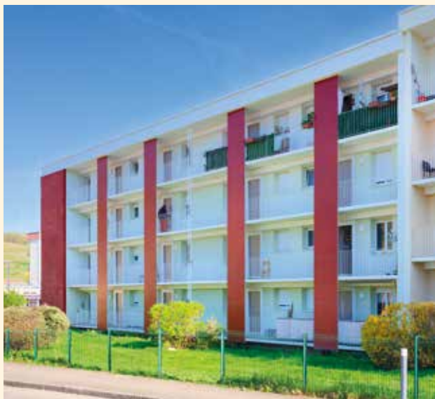
Réhabilitation de la résidence Vieil Armand à Guebwiller – coût global 3,1M€
